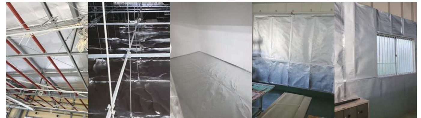
既存の屋根下 天井裏 保冷庫の床 勝手口 壁面
