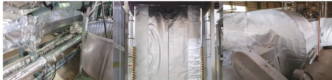
蒸気配管施工
