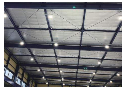
倉庫の屋根下
